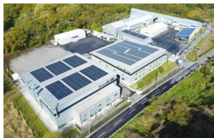
光一工業本社工場(福岡県飯塚市)
