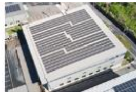
第二工場屋上
