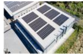
第三工場屋上
