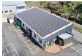
本社事務所屋上
