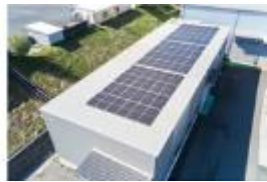
組立工場屋上
