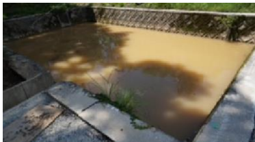
工事現場の貯水槽
