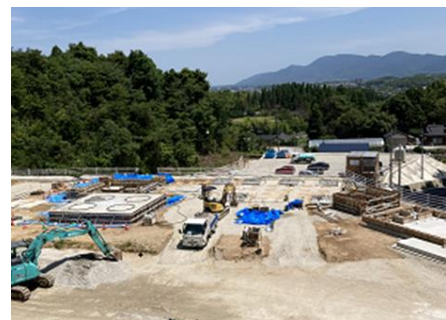
谷口組の工事現場
