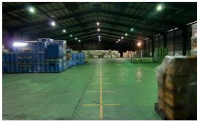
施工前(水銀灯 400W×30 灯)
