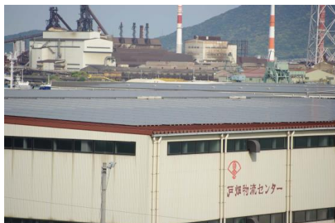
〈西港物流センター屋根〉
