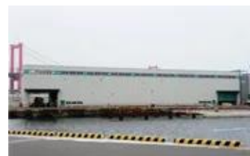
〈コイル材保管倉庫〉
