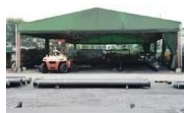
〈铸铁管塗装作業場〉
