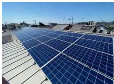
<屋根貸して事業の設置工事>
