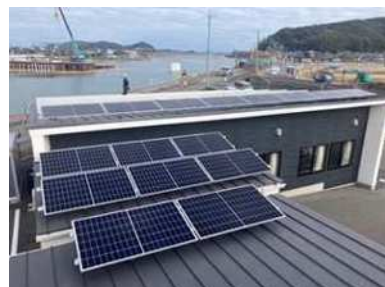
<太陽光発電設備設置工事>
